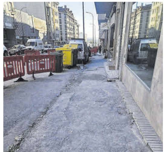
Uno de los tramos que está en obras en O Milladoiro. | Cedita
